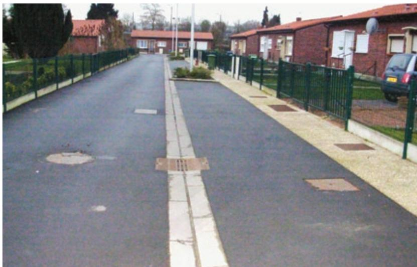
Revêtement imperméable : injection par un drain. (Cité du Rivage - Waziers)
